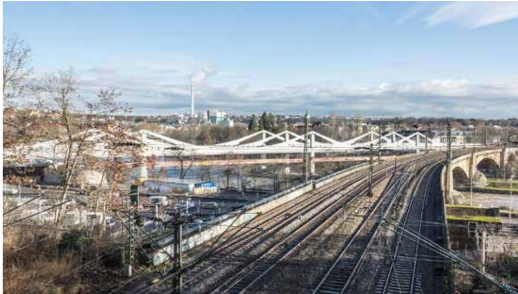
Nach Verlegung der S-Bahn auf die neue Brücke sind 4 Gleise für Fern- und Regionalverkehr verfügbar (Bild: Ulli Fetzer)
