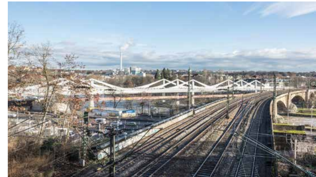
Nach Verlegung der S-Bahn auf die neue Brücke sind 4 Gleise für Fern- und Regionalverkehr verfügbar (Bild: Ulli Fetzer)
